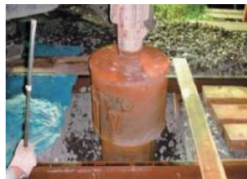
写真6. 施工の一例 ケーシング回転圧入
