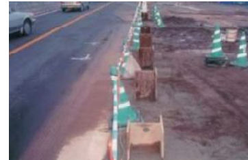
写真5. ③施工完了
