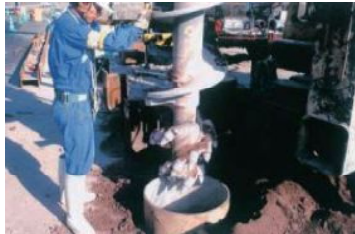
写真3. 施工状況 ①杭芯セット
