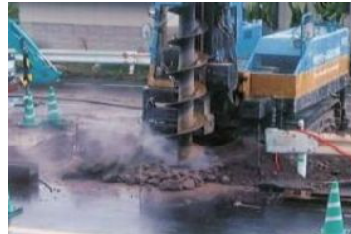
写真4. ②掘削の様子
