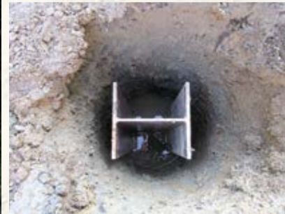
片側通行規制による 施工状況 (グラウト注入)
