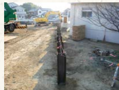
小学校及び住宅地 近接施工完了状況
