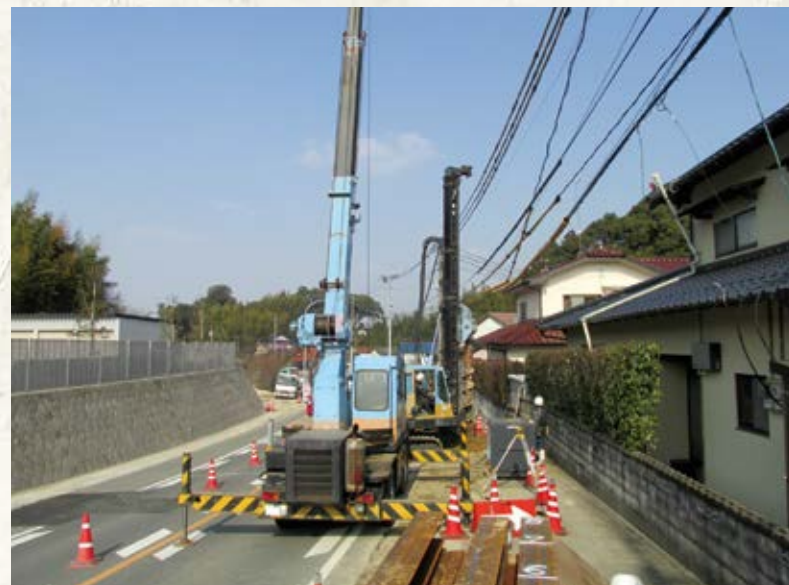
狭小地での災害復旧に伴う 土留め工事
