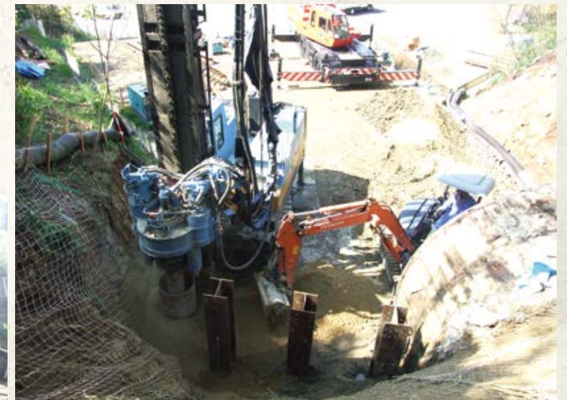
防塵機下部新設に伴う 土留め工事施工状況
