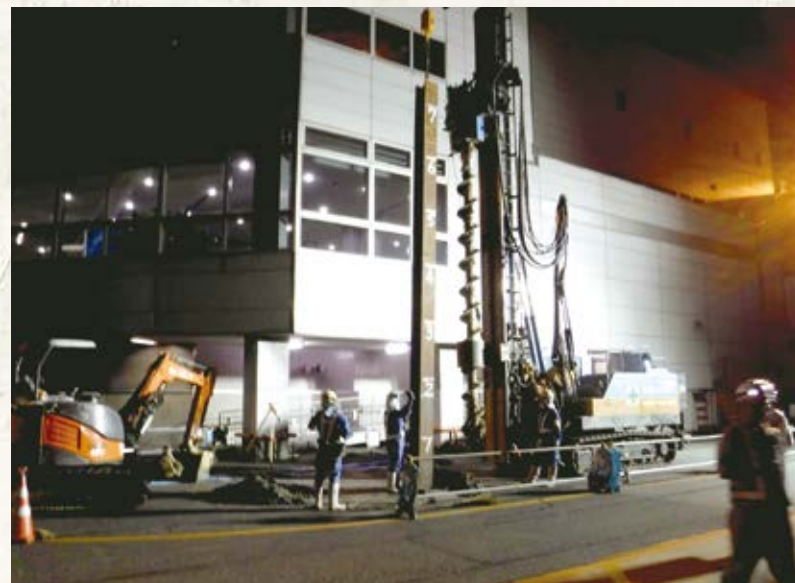
福岡空港内土留め工事 (夜間) 構造物近接施工状況
