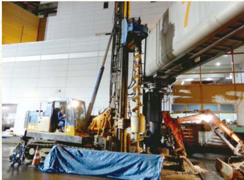
福岡空港内土留め工事 (夜間) 構造物近接施工状況
