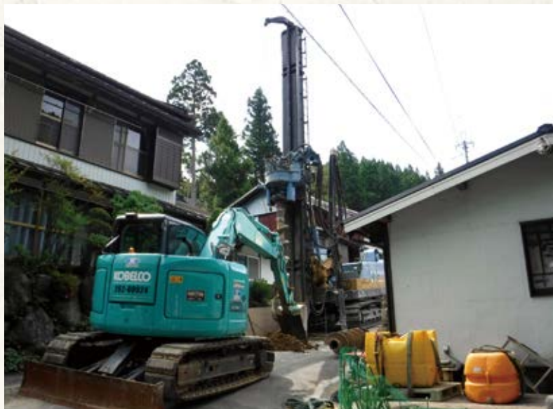
狭小地での災害復旧に伴う 土留め工事
