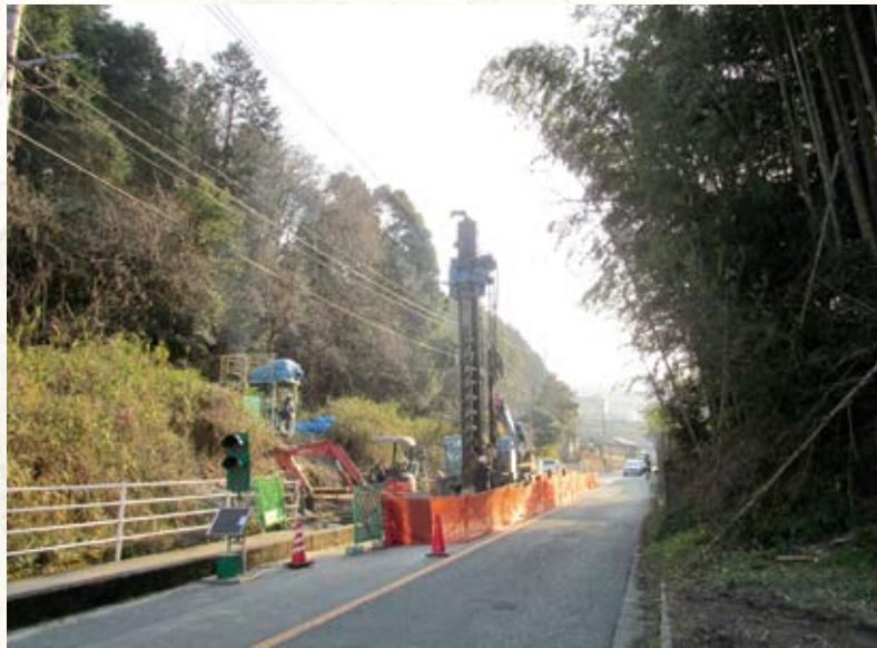
片側通行規制による 施工状況 (グラウト注入)
