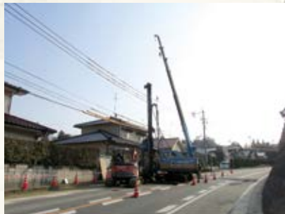
道路片側通行規制による 防護柵設置工事
