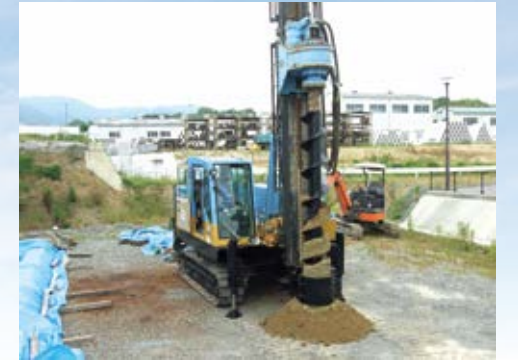
スーパーロックEXα掘削状況(完全乾式)
