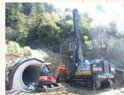
防塵機下部新設に伴う 土留め工事施工状況
