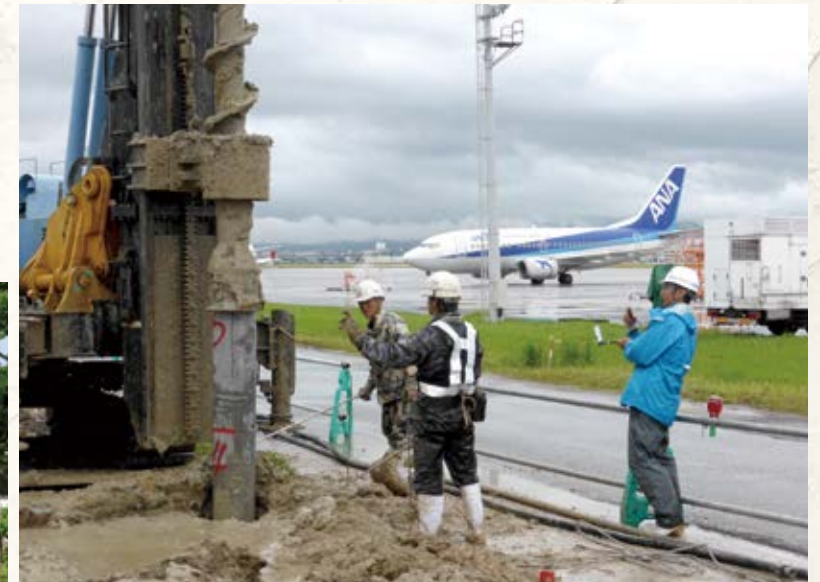
福岡空港内杭打ち工事 施工状況
