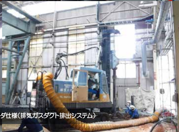
DHJ-12 工場内架空線下施工 短尺リーダ仕様
