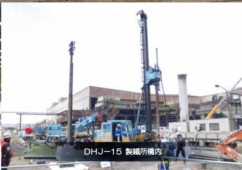
自社製作 PSPパイル(施工機械DHJ-25)
