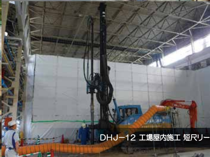
DHJ-12 工場内架空線下施工 短尺リーダ仕様
