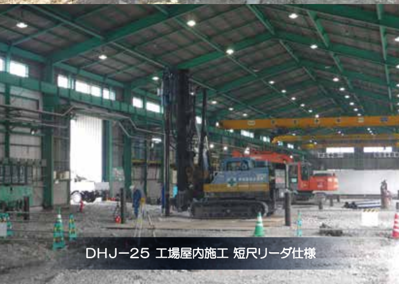
自社製作 PSPパイル(施工機械DHJ-25)
